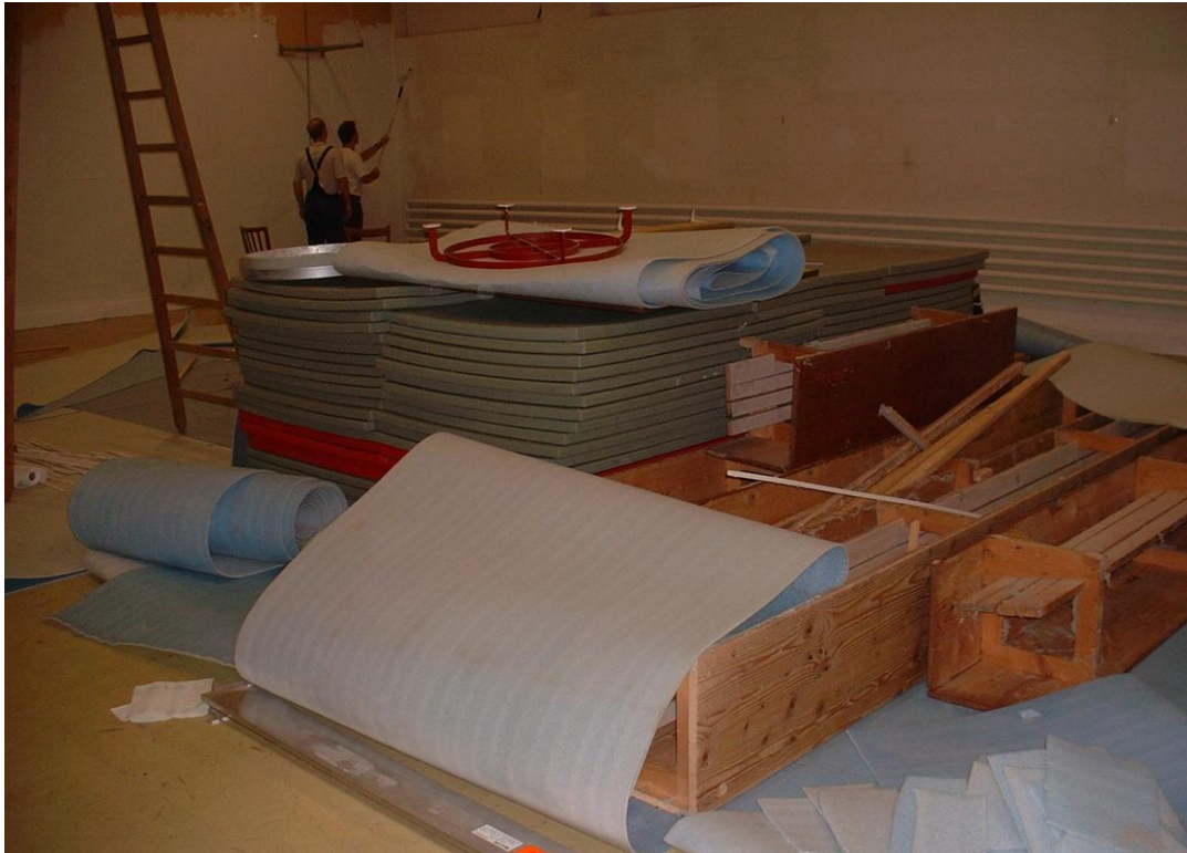
ABBILDUNG 30: RENOVATION DES DOJOS 2003 (QUELLE: RENÉ WIDTMANN)
